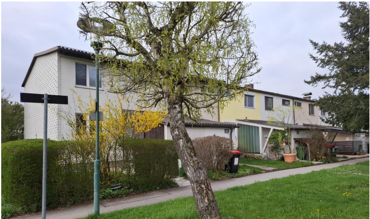
Abbildung 8 – Reihenhausanlage Liesingtalstraße / Hirschentanzstraße
