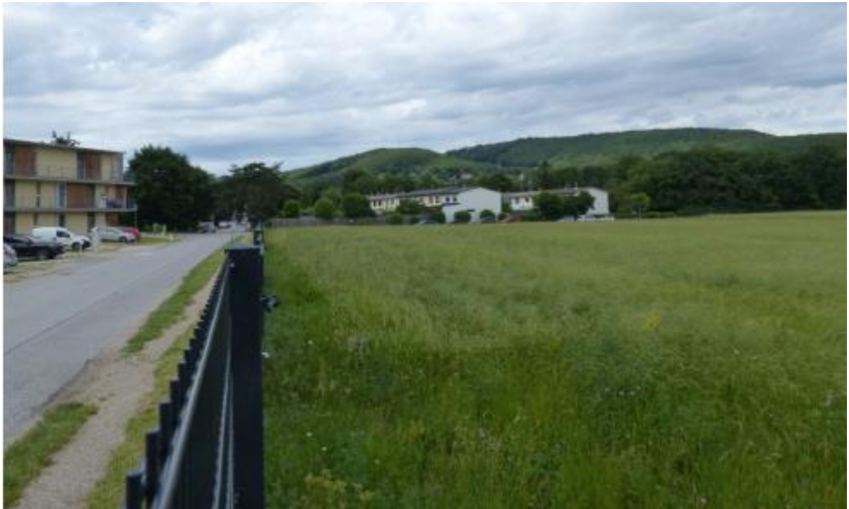
Bild 19 – 1350775: Liesingtalstraße, rechts das geplante Baufeld G, dahinter die Bebauung in der Liesingtalstraße 1 bis 47
